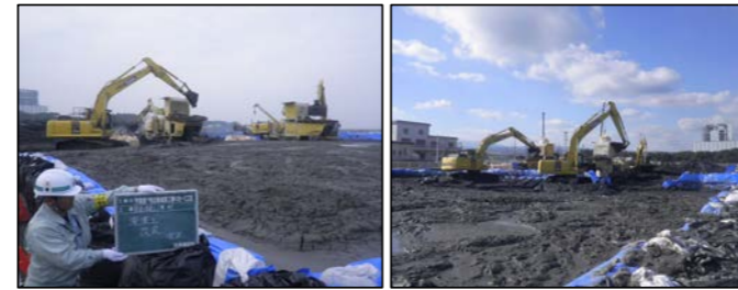
浚渫土改良工
