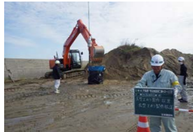
耐候性大型土のう製作・設置工
