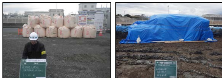
石灰系固化材(トソイル)搬入・養生
