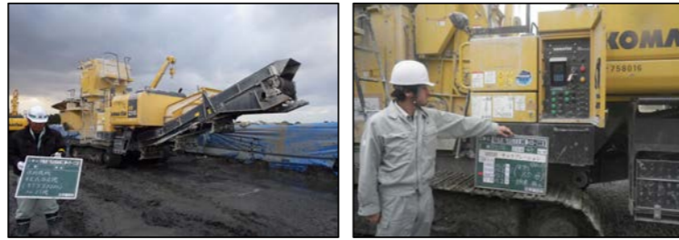
浚渫土砂含水比測定(140%以下)
