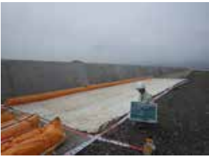
汚濁防止膜 カーテン長L=4.0m
