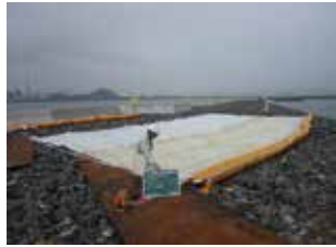
汚濁防止膜 カーテン長L=9.0m
